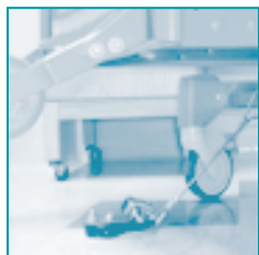
La cama está anclada en el suelo para evitar su utilización como barricada. En general, se cree que es una medida de seguridad.
