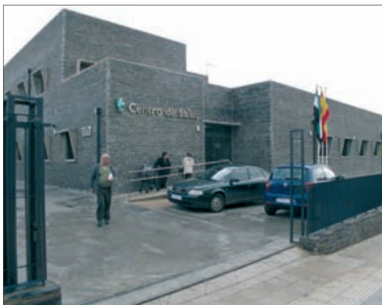
La pizarra reviste el nuevo edificio del CS en San Vicente.
