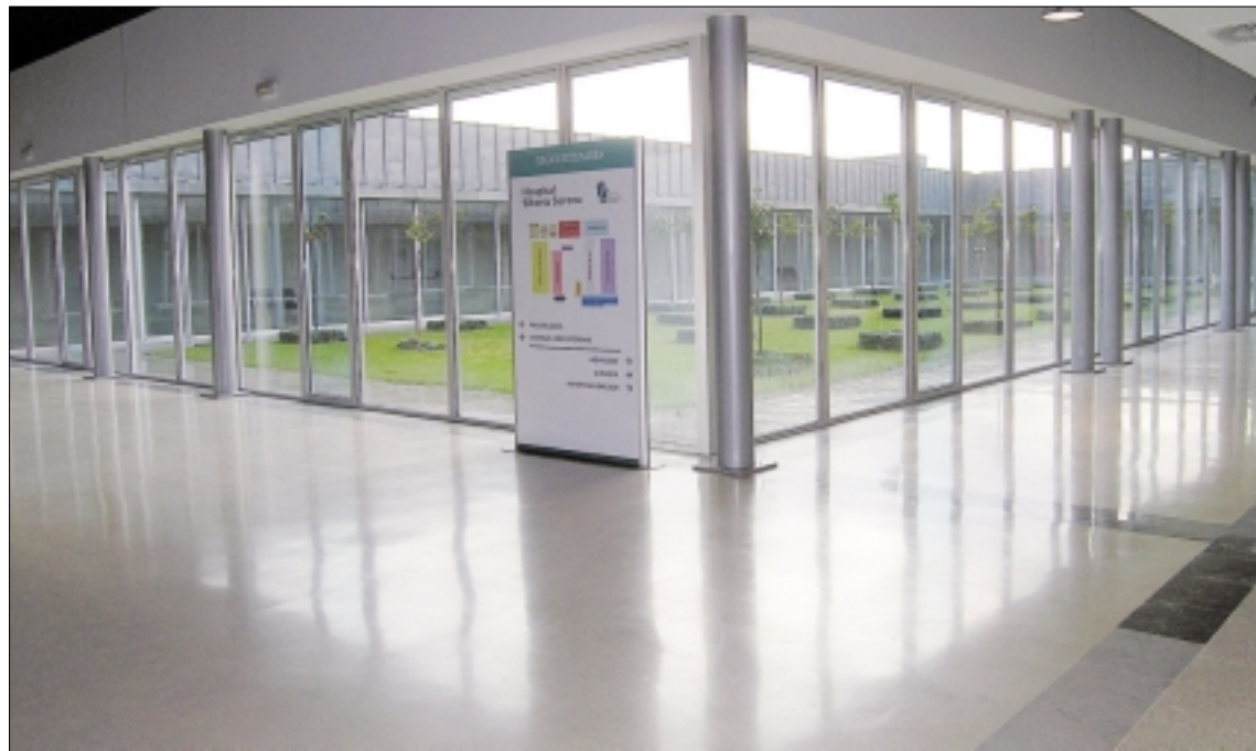
Patio central del Hospital 'Siberia-Serena'.
