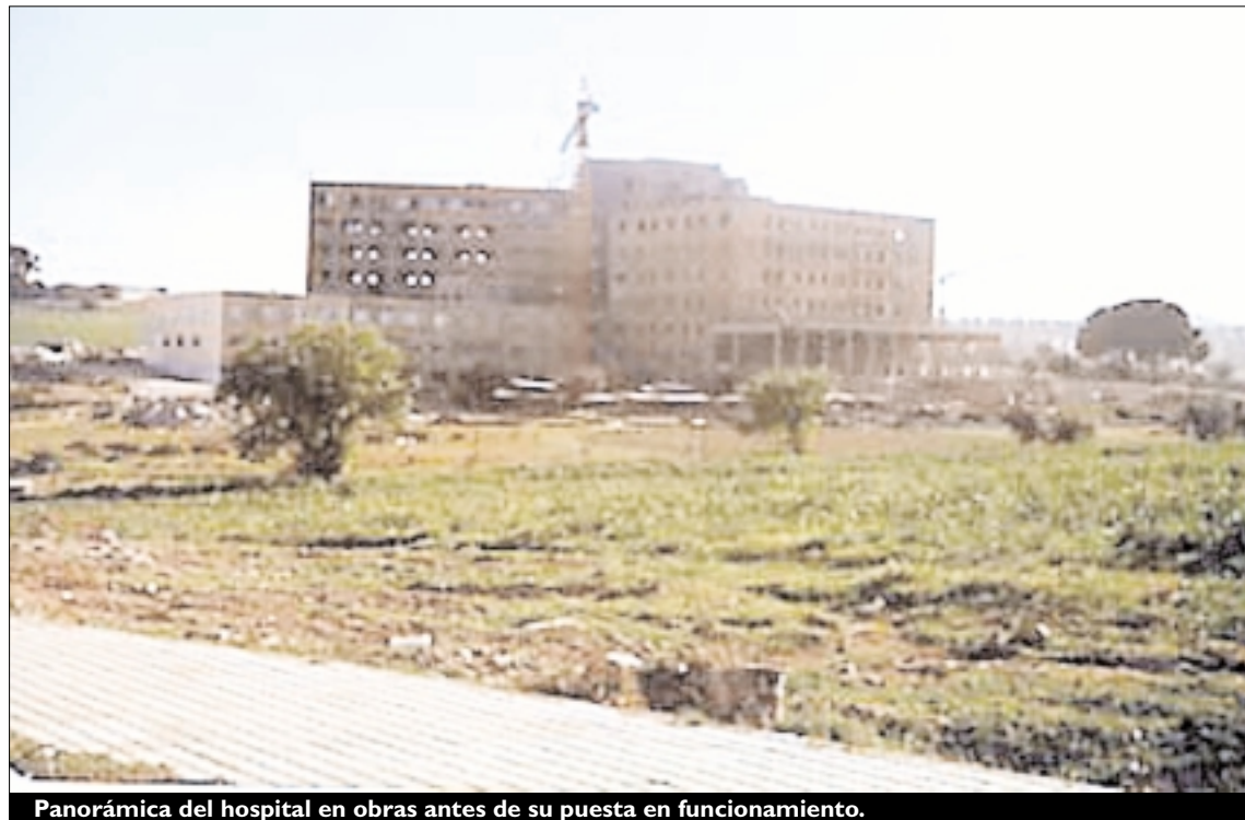
Panorámica del hospital en obras antes de su puesta en funcionamiento.
