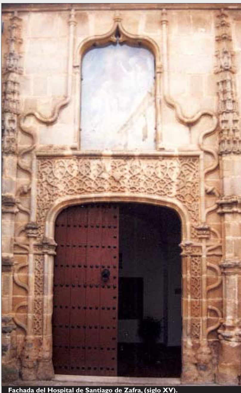
Fachada del Hospital de Santiago de Zafra, (siglo XV).
